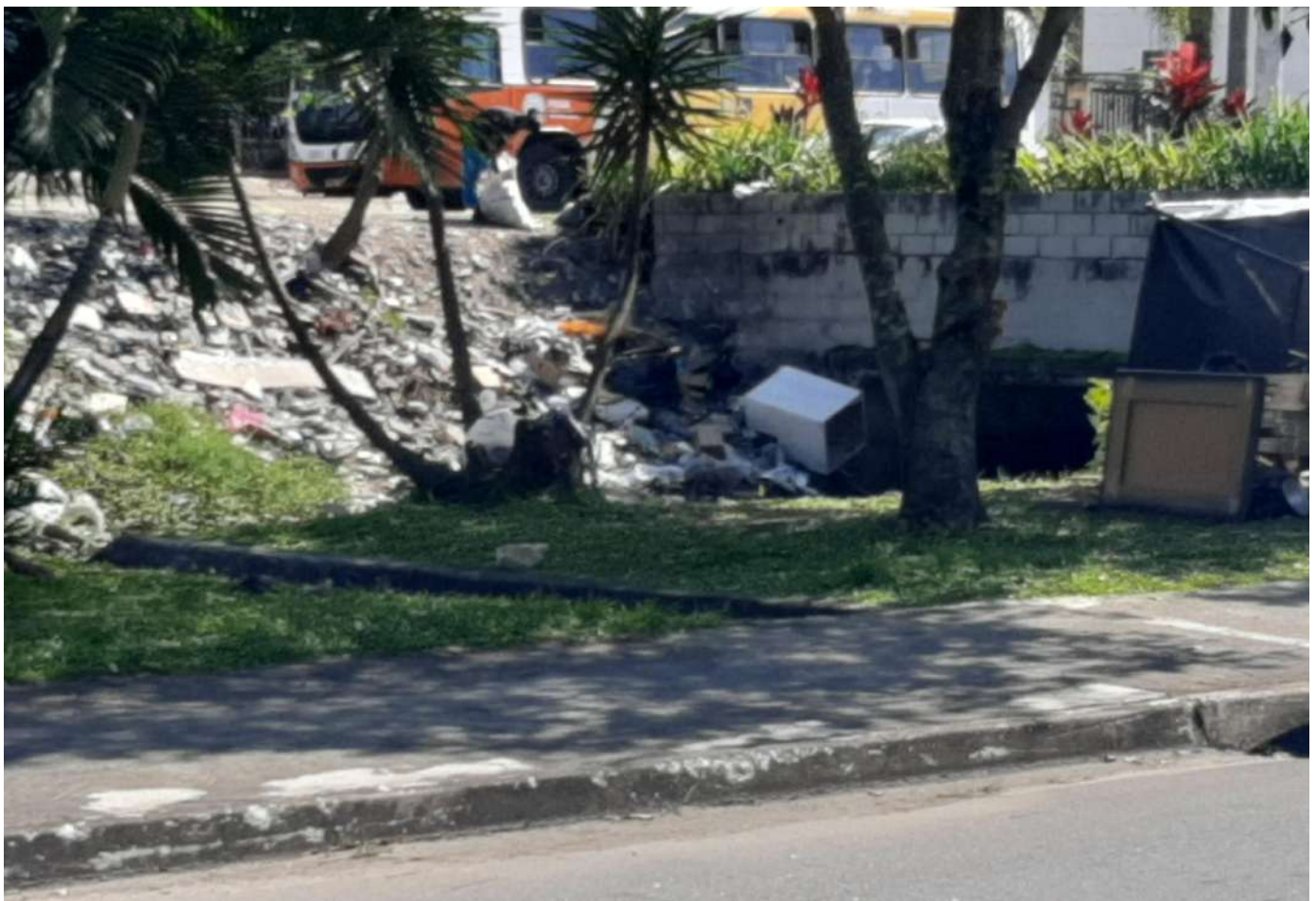
Foto Tirada: 22/11/2021- Canal da Avenida dos Trabalhadores, próxima a Cooperativa Coopervida
