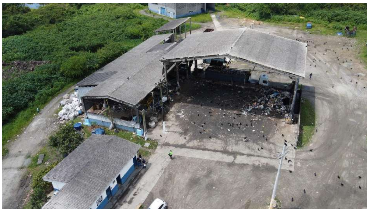
Ponto de transbordo Bertioga
