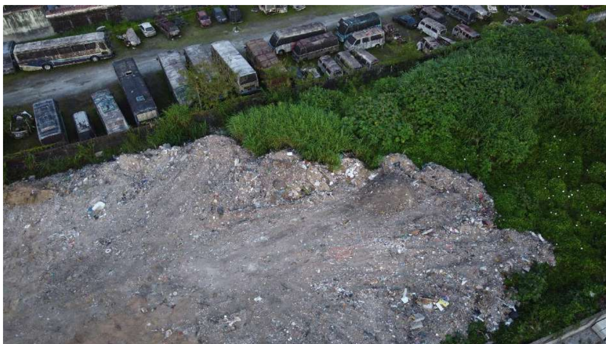
Ponto de aterro e descarte cercado
