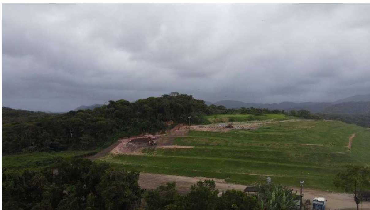
Aterro Sanitário Peruíbe
