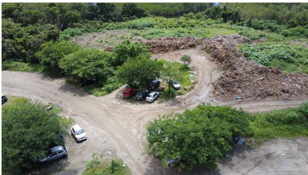
Ponto de transbordo Bertioga
