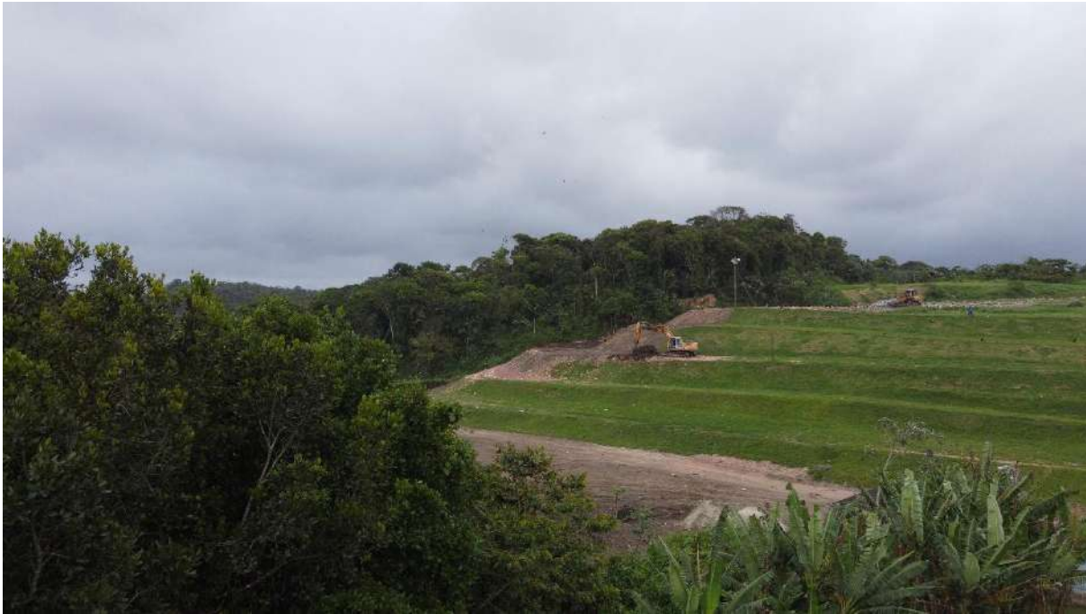
Aterro Sanitário Peruíbe
