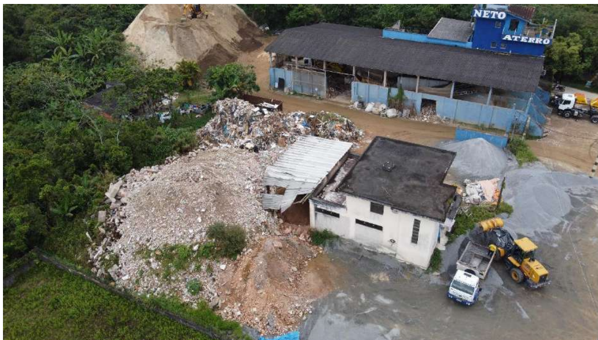
Pontos de armazenamento de material e entulho a céu aberto Bertioga
