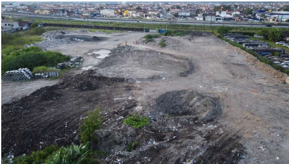
Ponto de aterro e descarte cercado
