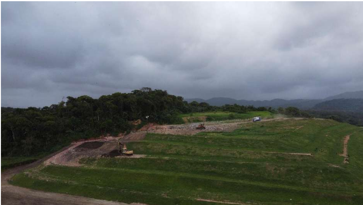
Aterro Sanitário Peruíbe
